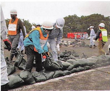
市職員と市民による水防工法作成の様子
