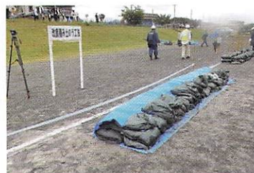
②改良積み土嚢工法
