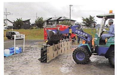
③鋼板防護工法
