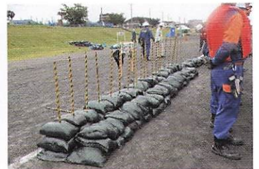
①積み土嚢工法
